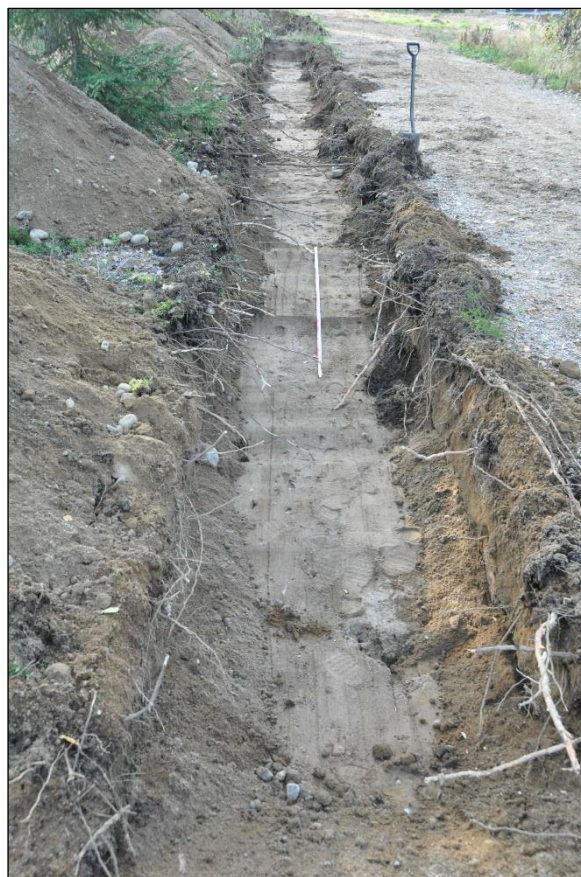
Pohjaan kaivettuna. Koillisesta.
