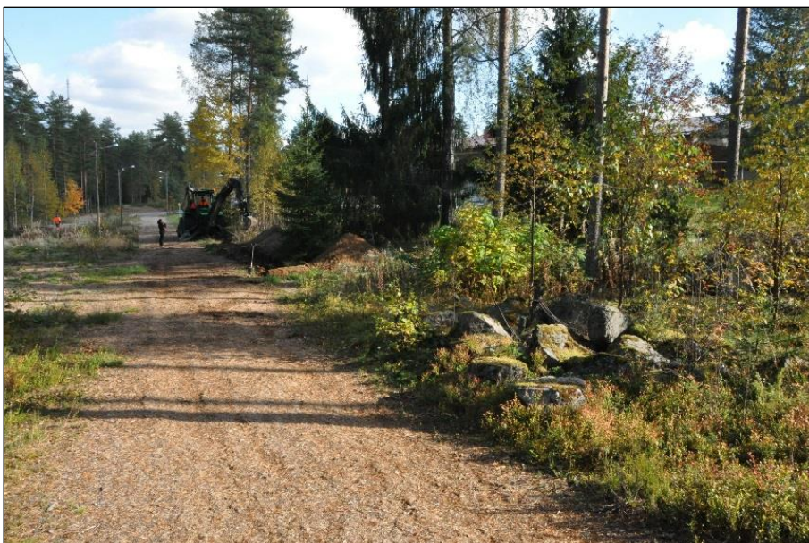
Koeojan 2 sijainti kaivinko- neen kohdalla.
