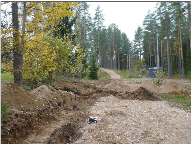
Koeojat kaivettuna 1, 2 nykyisen pururadan suuntaisesti ja 4 sen poikki. Kuvattu lounaaseen.
